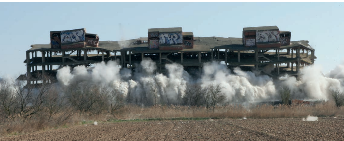
>> Demolició de l'edifici del Fluvià Nàutic de Sant Pere Pescador. (Foto: AJUNTAMENT DE GIRONA. CRDI. FONTS JOAQUIM NADAL FARRERAS.)
