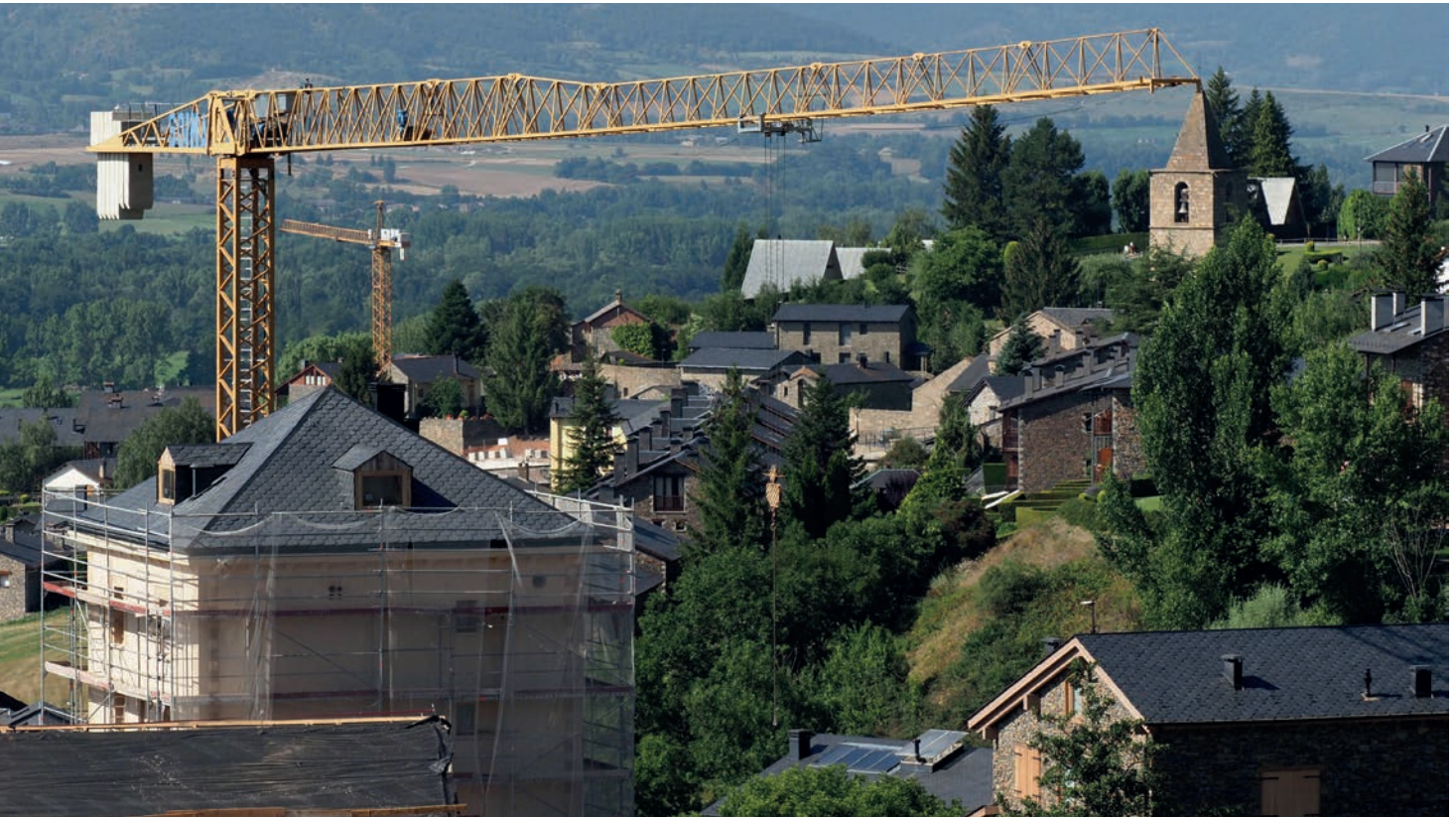
>> Construcció de xalets a Bolvir, a la Cerdanya. (Foto: PERE DURAN)
