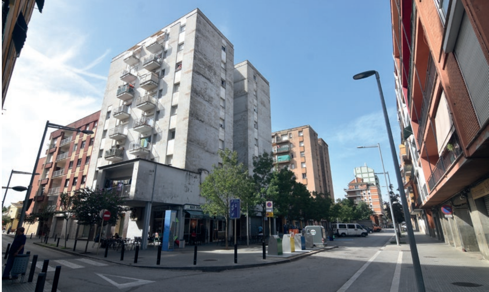
>> Els habitatges del Barri Centre són edificis verticals, alguns dels quals estan deteriorats. (Foto: JOAN AURELI MARTÍ)
