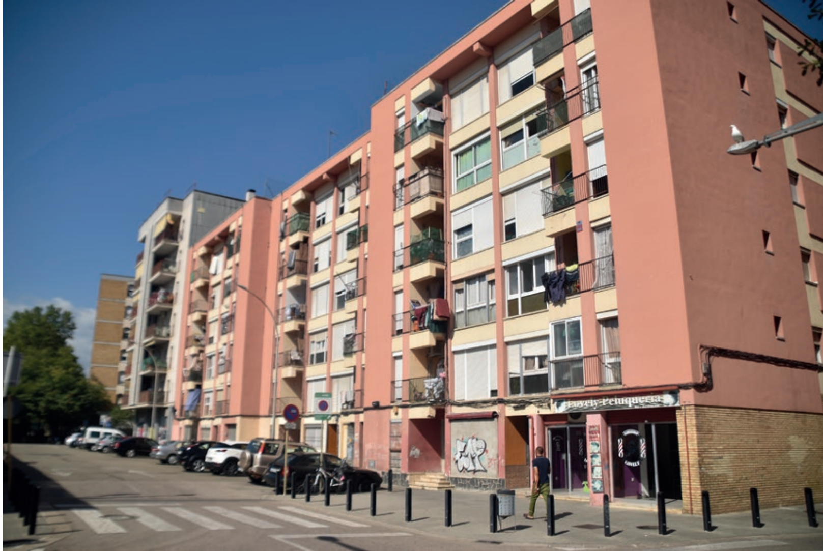
>> La majoria dels edificis van ser construïts en la dècada dels setanta. (Foto: JOAN AURELI MARTÍ)
