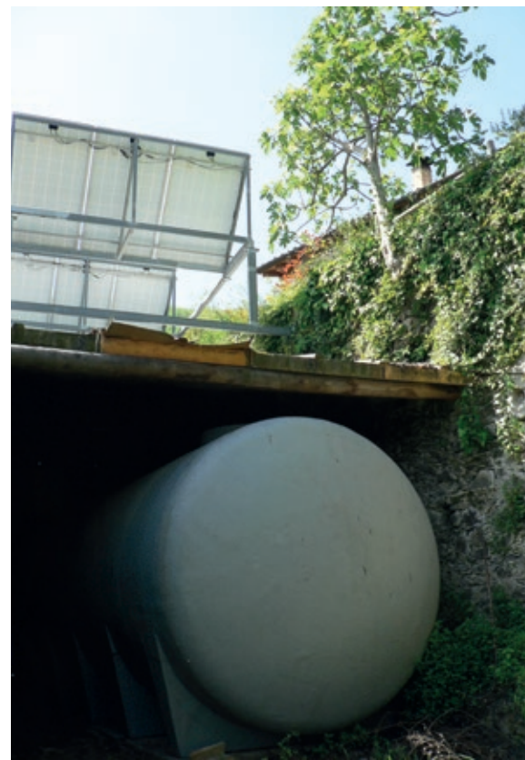
>> Les plaques solars a sobre del dipòsit d'aigua que permeten l'autonomia de la casa del Plantadís.
