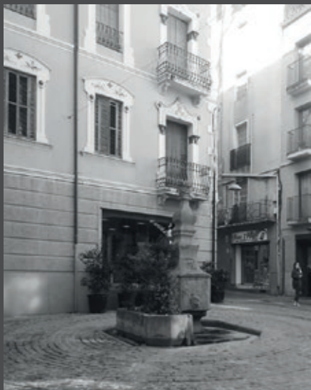
>> Estat inicial de la font del Conill. (Foto: UNPARELLD'ARQUITECTES)
