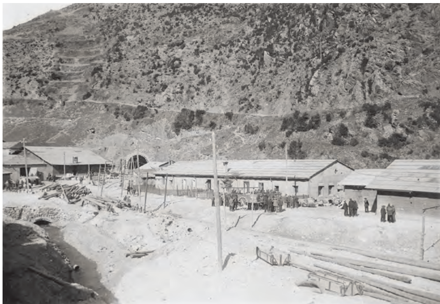
>> Obres de construcció del túnel de Toses. Boca sud, amb les instal·lacions necessàries per donar servei als treballadors arribats d'arreu de l'Estat. (Foto: Museu Etnogràfic de Ripoll . Arxiu Comarcal de Ripoll . Fons Nicolau Coma i Llitjós. )
