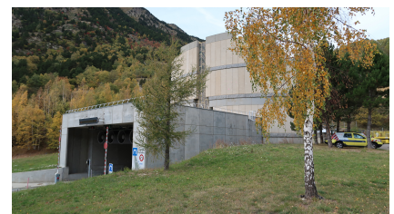
>> Entrada del túnel del Pimorent pel costat de la Cerdanya.
