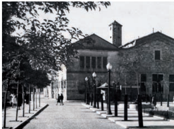
>> El convent –després caserna– de Sant Francesc de Paula, demolit a final dels anys seixanta del segle xx per deixar pas als edificis del pla Perpiñà.
