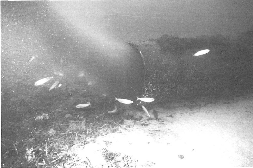
Figura 5.- Fotografia de la sortida d'un emissari (cedida pel Consorci Costa Brava). Es pot observar la ràpida tendència de l'aigua residual a dirigir-se cap la superfície, on formarà la ploma. S'observa la presència de bogues i llísseres.
