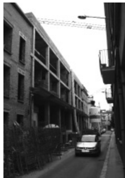
Carrer Rentadors, construcció d'habitatges a l'emplaçament d'Indústries Ferrer i de l'edifici de la fàbrica del gel. Densificació del centre urbà.
