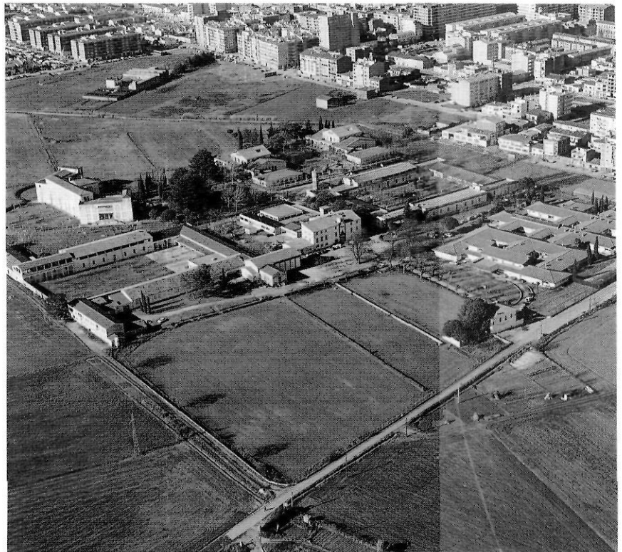
Vista aèria del Psiquiàtric abans d'iniciar les obres del Parc Hospitalari.
