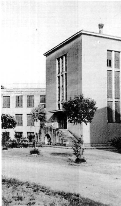
Perspectiva de l'edifici construït al Psiquiàtric en l'etapa republicana.
