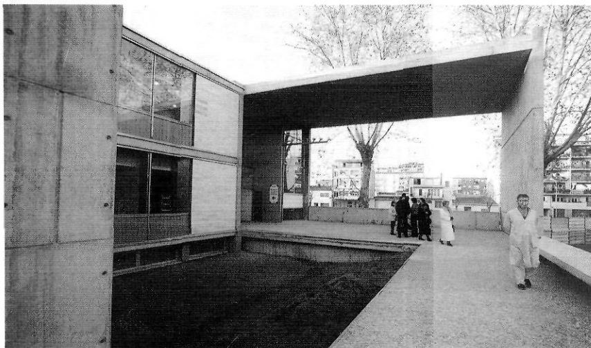
Accés al nou edifici SALT.
