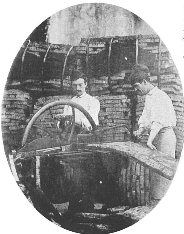
Llescant suro amb una màquina Noué Derbuel.
