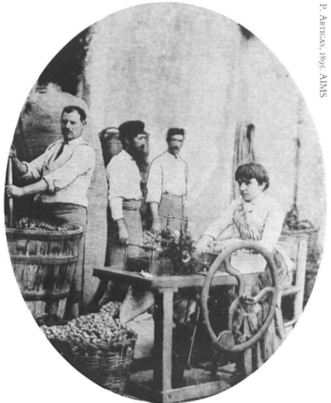
Partint taps a pedal amb una màquina Batet-Vidal.
