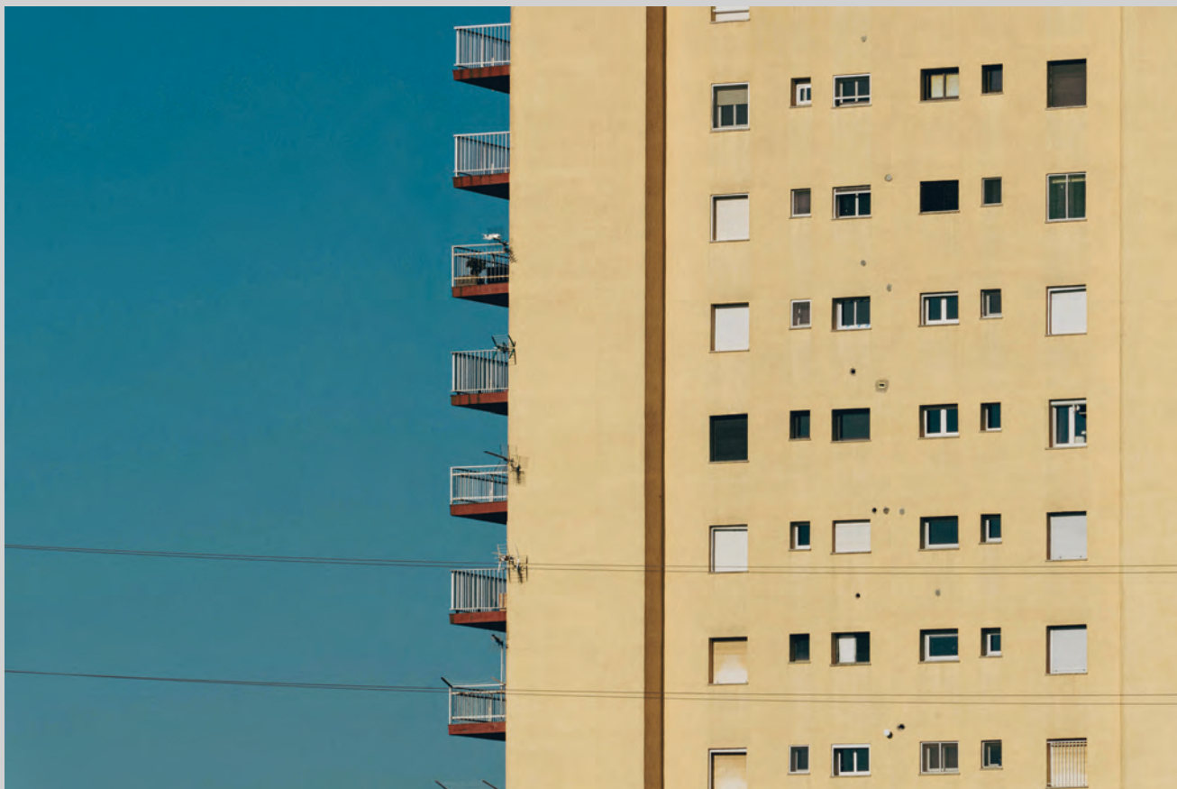
>> Edifici d'apartaments a la urbanització Bon Relax, Sant Pere Pescador.
