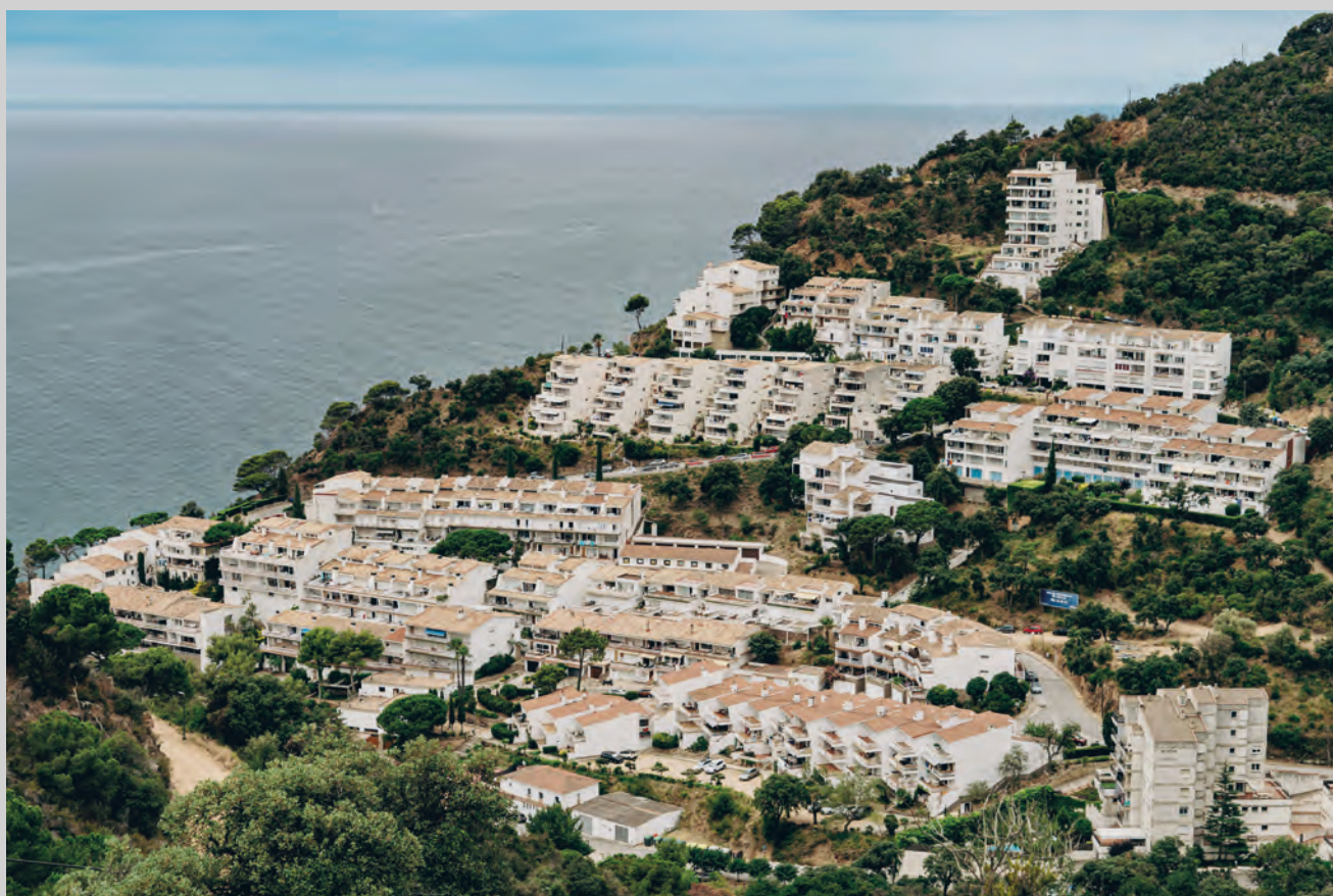
>> Urbanització Cala Salionç, Tossa de Mar.
