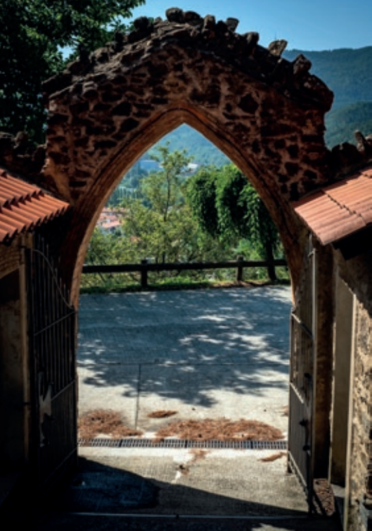
>> Porta del cementiri, al cim de Sant Cristòfol.
