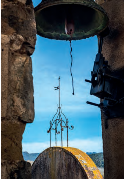
>> Vista des de l'interior del campanar de l'església.
