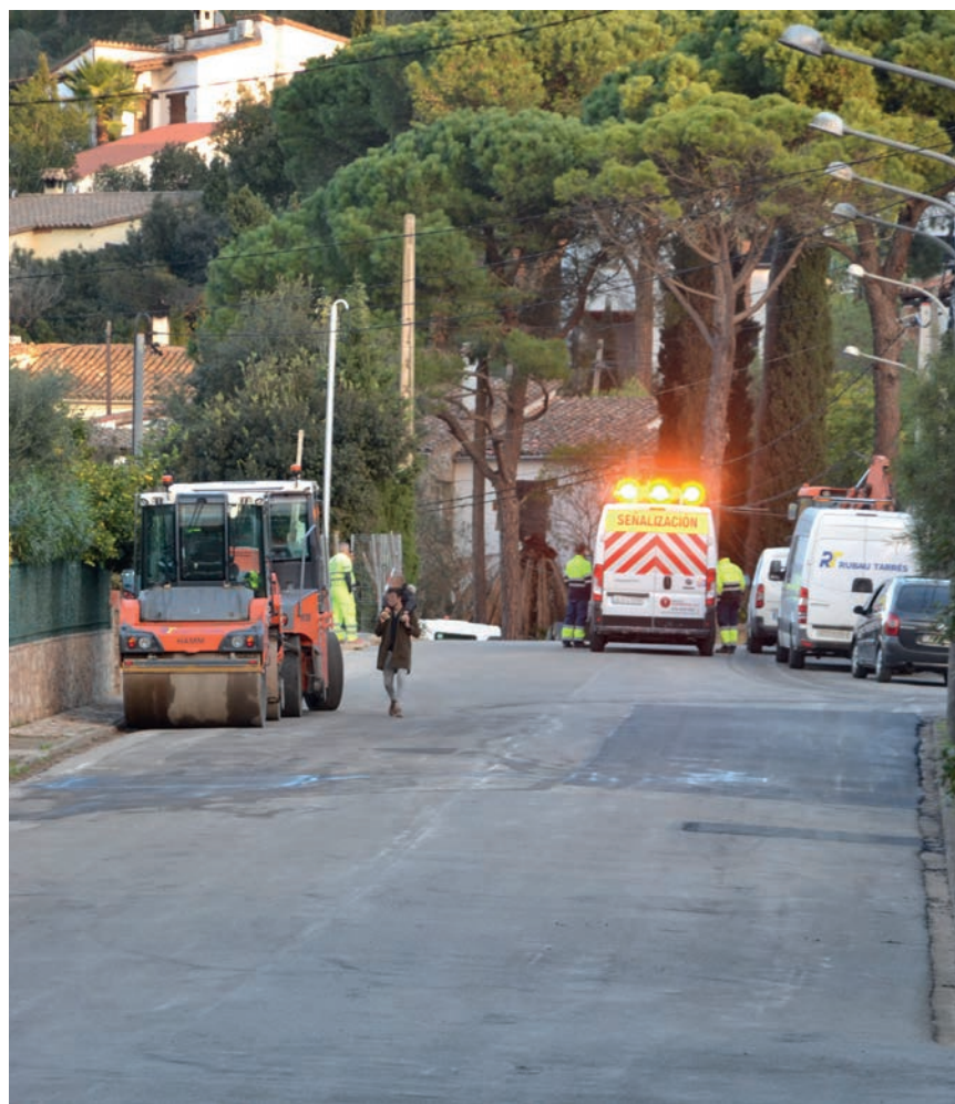
>> Treballs de reparació de punts d'asfalt malmès, en un dels carrers del Residencial Begur.
