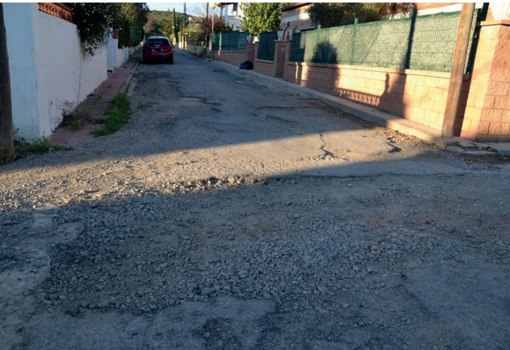
>> Estat deplorable del paviment als carrers de la urbanització les Dunes, de l'Estartit.
