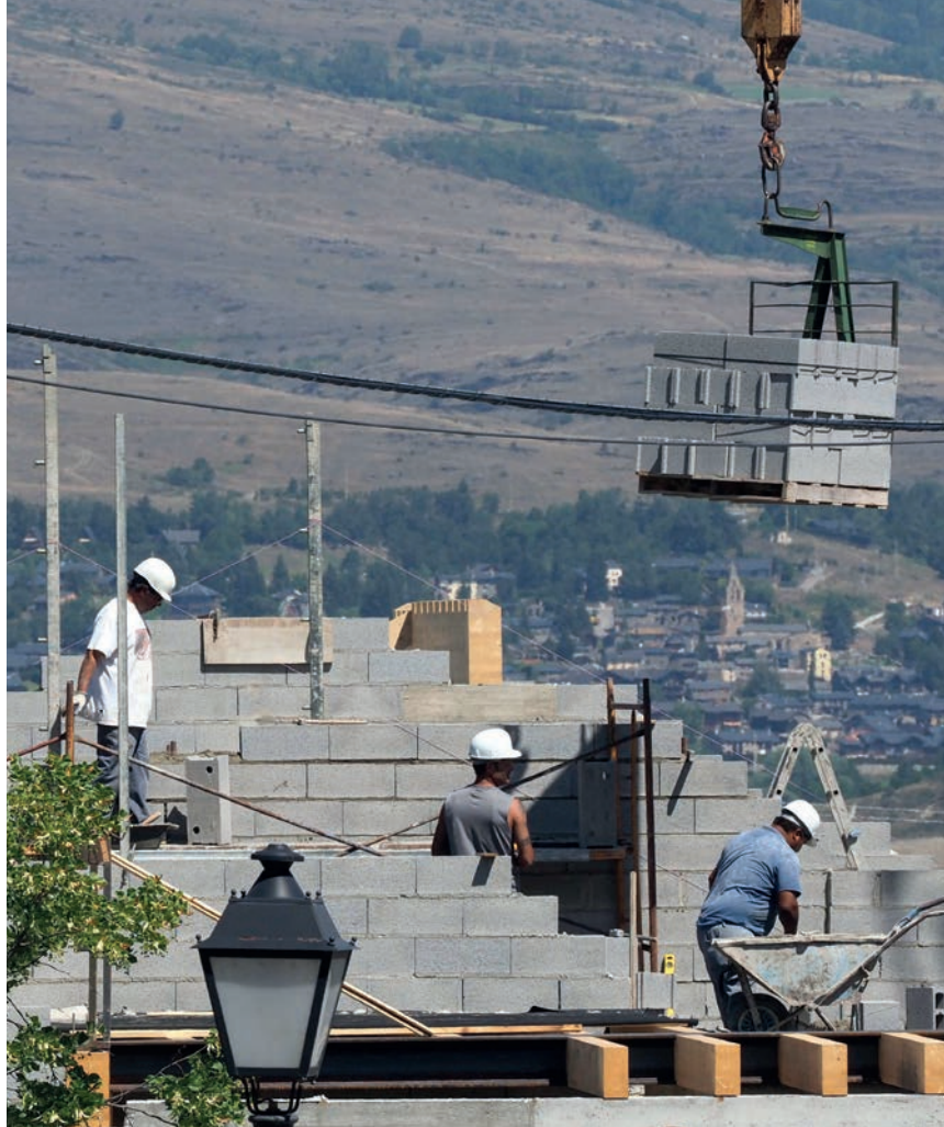
>> Construcció de nous habitatges a Alp. (Foto: PERE DURAN)
