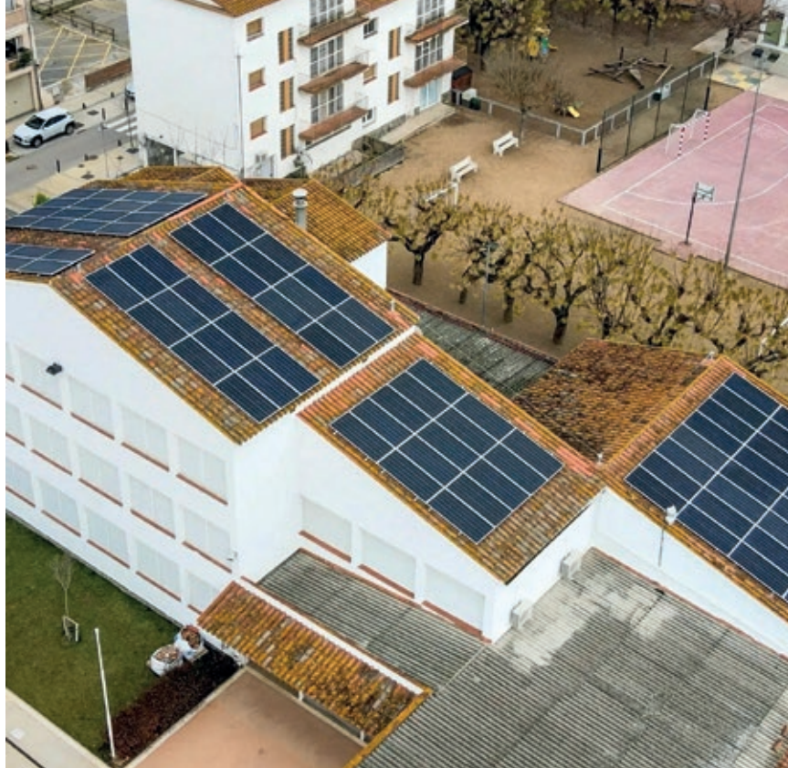
>> Instal·lació de plaques fotovoltaïques a l'Escola La Vall del Terri, de Cornellà del Terri. (Foto: ELECTROFLUXE)
