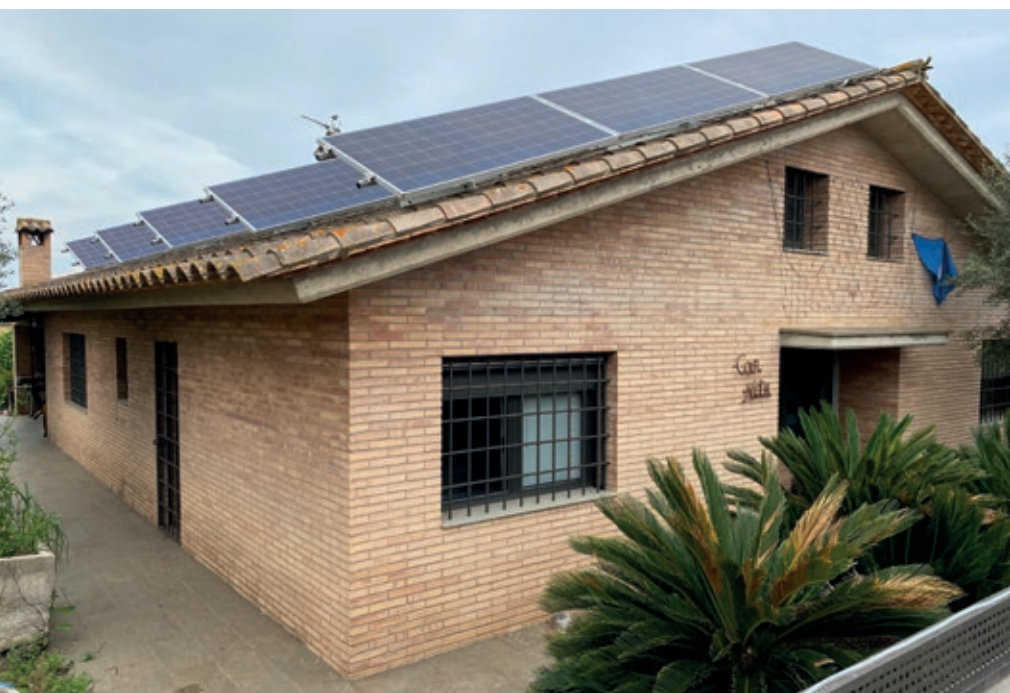
>> Instal·lació de plaques fotovoltaïques a Sant Jordi Desvalls. (Foto: BÀRBARA JULBE)
