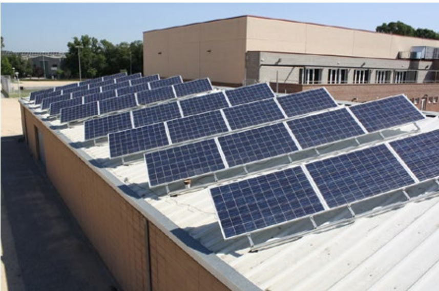
>> Instal·lació de tres cobertes fotovoltaïques sobre teulades municipals de Riudarenes. (Foto: SOM ENERGIA)
