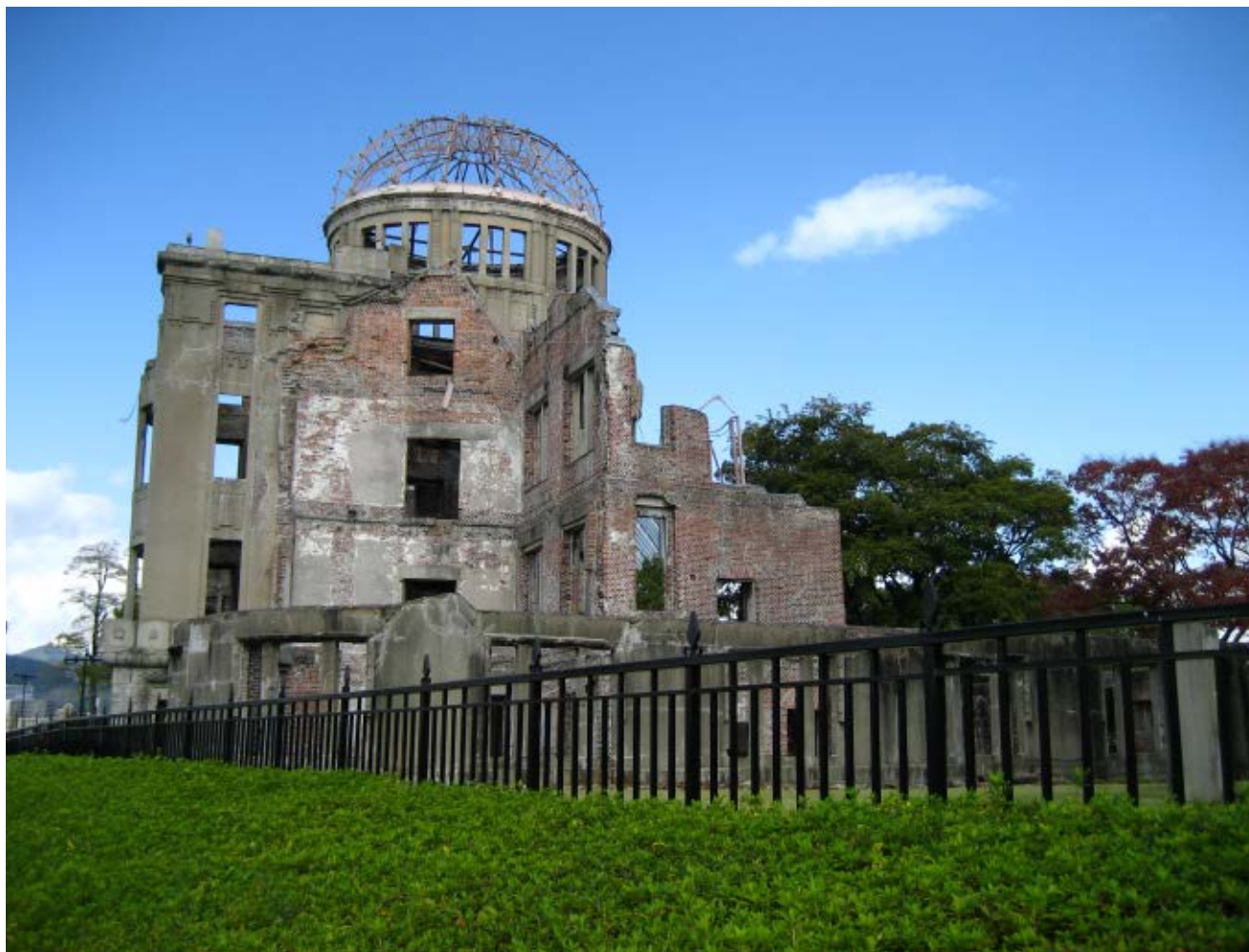
>> Memorial de la Pau d'Hiroshima o cúpula de Genbaku, l'estructura de l'únic edifici que va quedar a la zona on va esclatar la primera bomba atòmica el 6 d'agost de 1945. Es va decidir deixar-lo sense reconstruir per poder mostrar l'abast de la destrucció. (Foto: MONTSERRAT GRAU)
