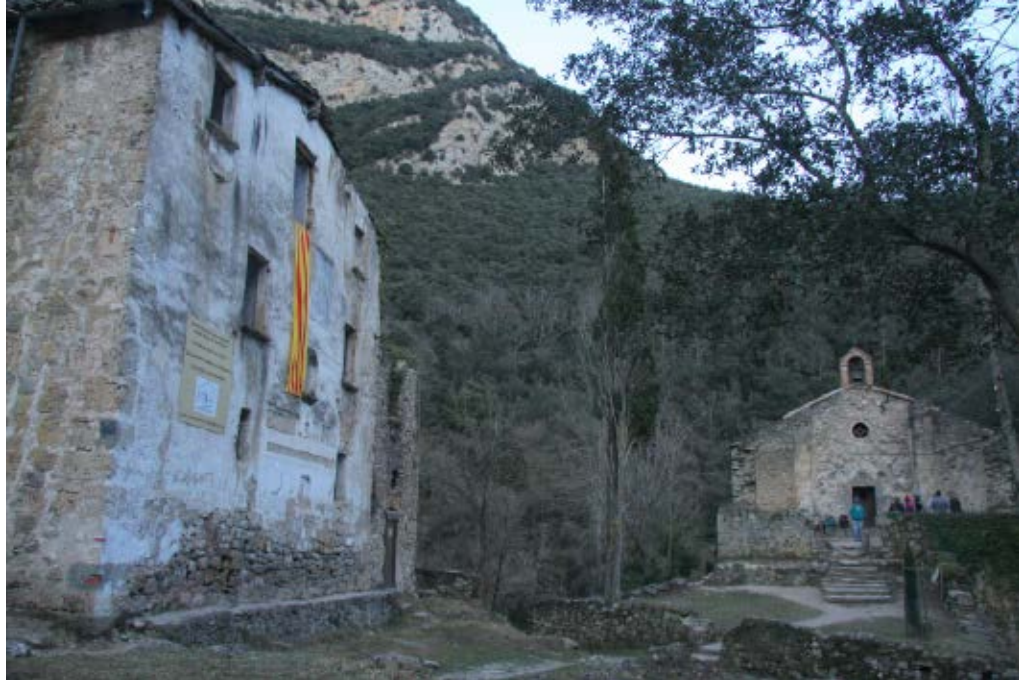
>> L'església i el refugi, abans de la restauració.
