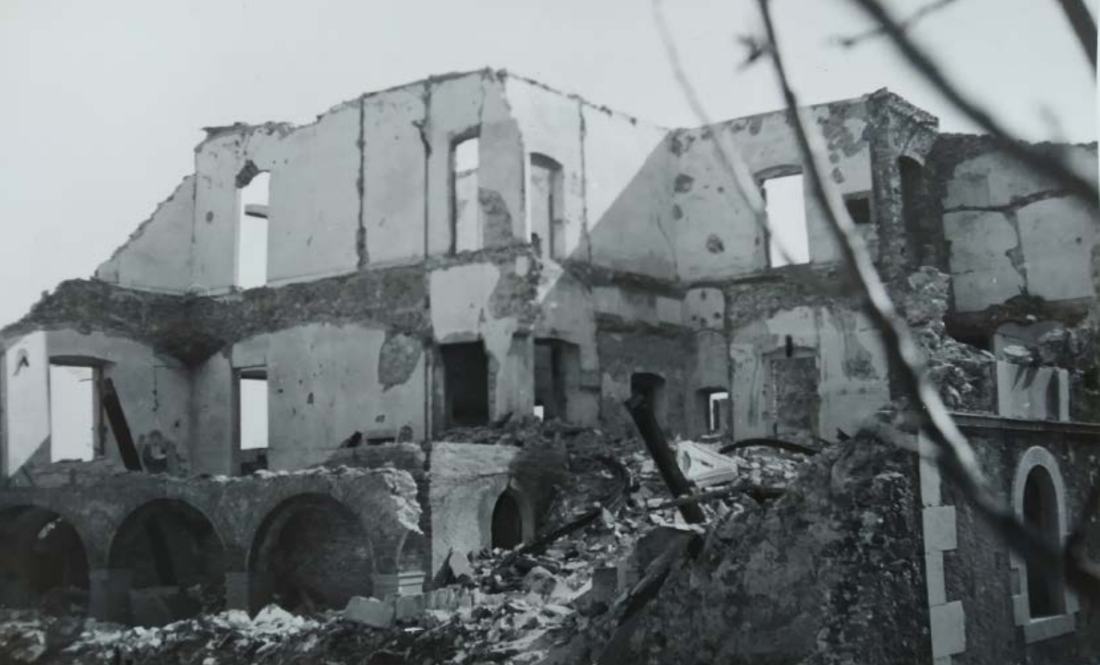
>> El nucli de Llers, exclòs els Hostalets, tenia 429 edificis. En van quedar totalment destruïts 155, parcialment destruïts 60 i amb altres afectacions 214.
