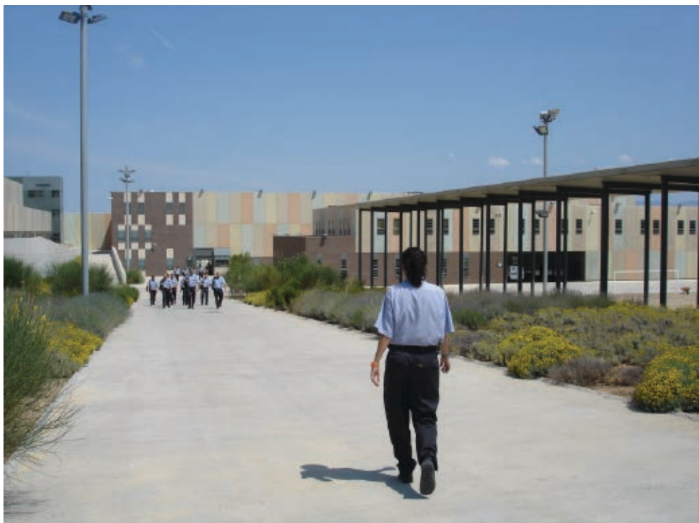
>> El Centre Penitenciari del Puig de les Basses es va adaptar a l'orografia de la zona, per evitar un impacte visual.
