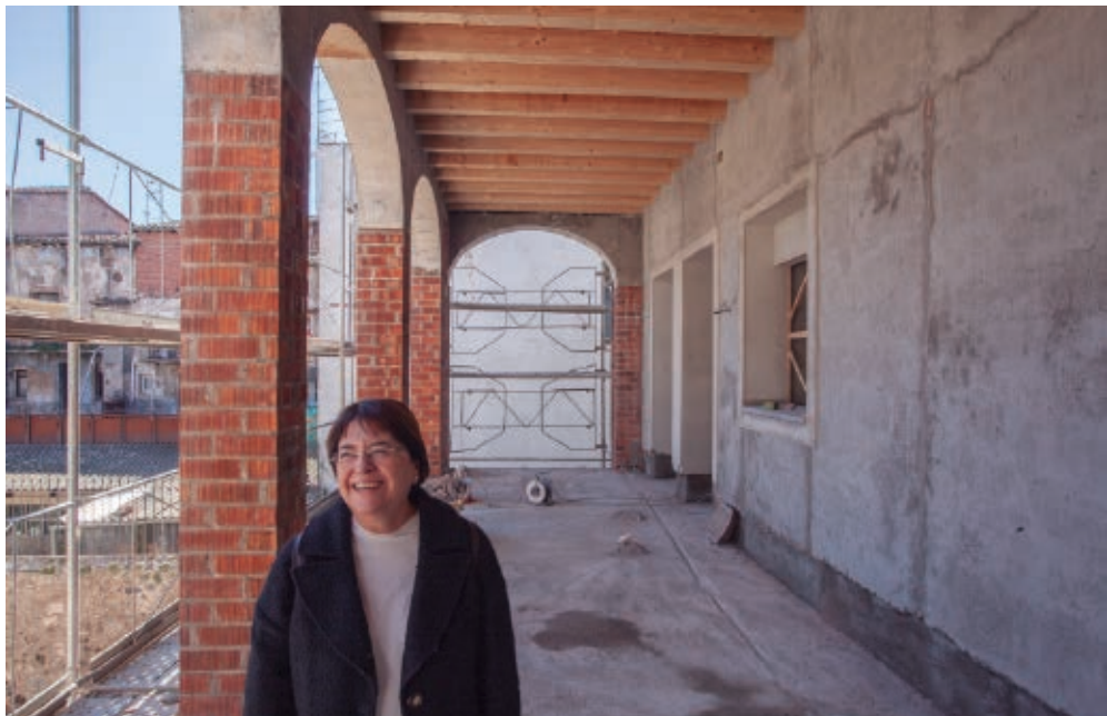
>> Una visita recent a les obres de Can Resplandis.
