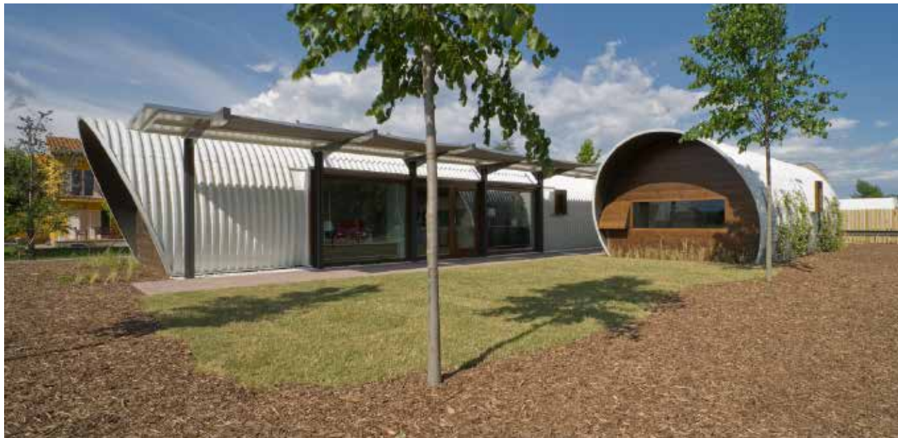
>> Habitatge aïllat modular d'anells mixtos d'acer i formigó amb fibres, ubicat a la urbanització de Cal Ferrer Pagès, a Vilobí, d'LPR Arquitectes, Construccions Busquets, Fusteria Danés i Prefabricats Planas, de l'any 2013. (Foto: NEWLIFECONCEPT. LOURDES JANSANA.)
