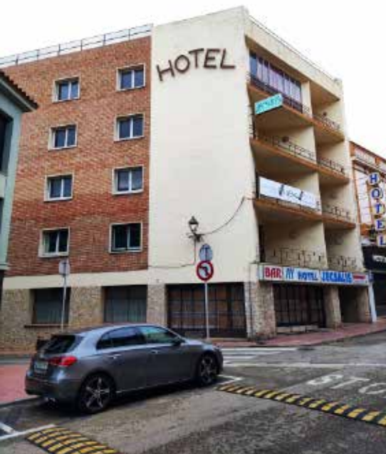
>> Edifici per al projecte Walden XXI a Sant Feliu de Guíxols. (Foto: JOAN VICENTE)
