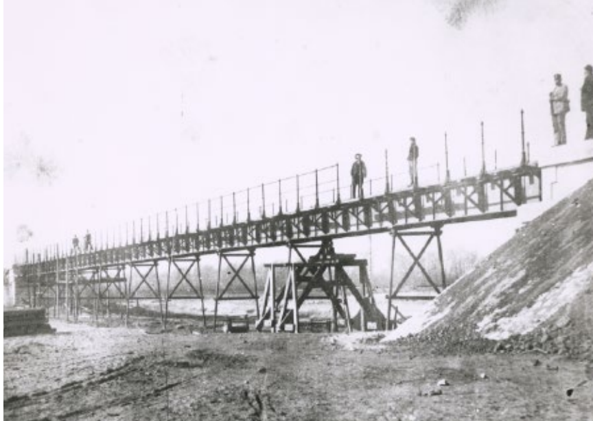
>> Construcció d'un pont sobre la Muga l'any 1890. (Font: AJUNTAMENT DE GIRONA. CRDI.)
