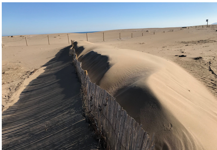
>> Sistema de retenidors sedimentaris per recuperar morfologies dunars a Sant Pere Pescador.
