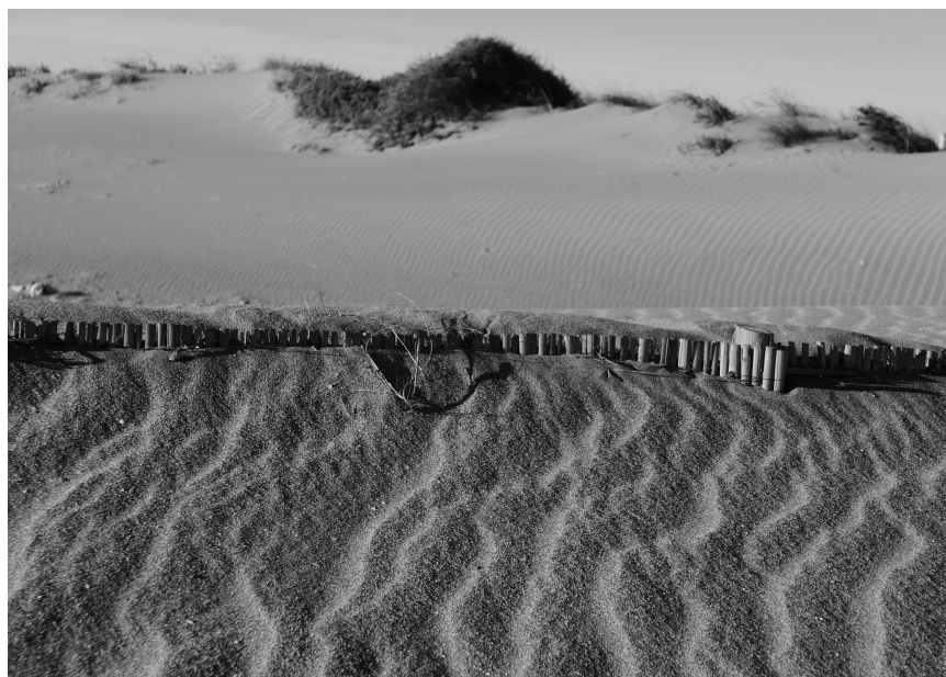
>> Sistema de retenidors sedimentaris per recuperar morfologies dunars a Sant Pere Pescador.
