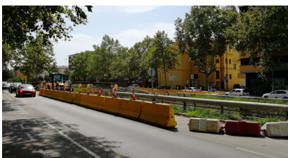
>> Obres a banda i banda del carrer Güell per fer els accessos al pont del Dimoni.
