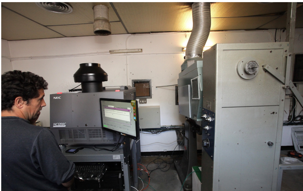
>> Instal·lació del nou projectador digital al Cinema Truffaut de Girona.
