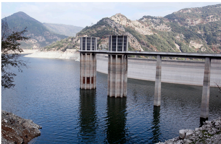
>> Part anterior de la presa i les dues torres de captació. (Autoria: MARC MARTÍ)
