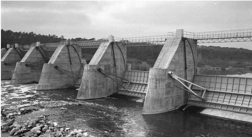
>> Les columnes de l'interior del pantà de Susqueda, durant la seva construcció. (Font: ENDESA)
