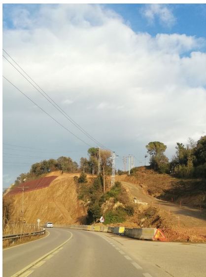
>> Obres a l'N-141e, a la Pilastra, a l'entrada est de Bescanó.
