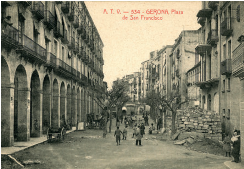
>> Vista parcial de la plaça del Gra, posteriorment avinguda de Sant Francesc, 1905-1911. A la dreta, la Encomienda de Isabel la Católica.
