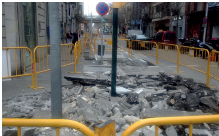
>> Obres del carril bici a l'avinguda de Santa Eugènia.
