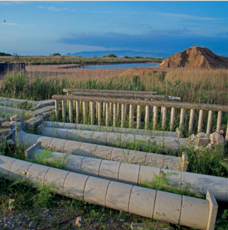
<< Restes dels treballs de desurbanització amb muntanyes de la terra que s'extreu per recuperar la maresma.
