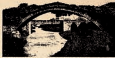
Fig. 1.º Vista general del puente sobre el río Güell. Vista general.
