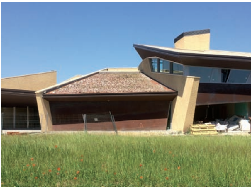
>> Nou edifici de l'Ecomuseu de la Vall d'en Bas, amb una arquitectura que no té res a veure amb la de la Vall.
