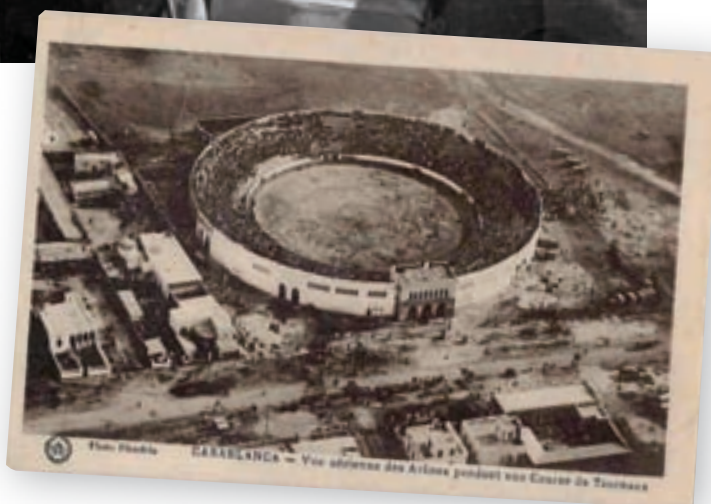
>> Imatge de la plaça de Les Arènes de Casablanca, avui ja enderrocada.
