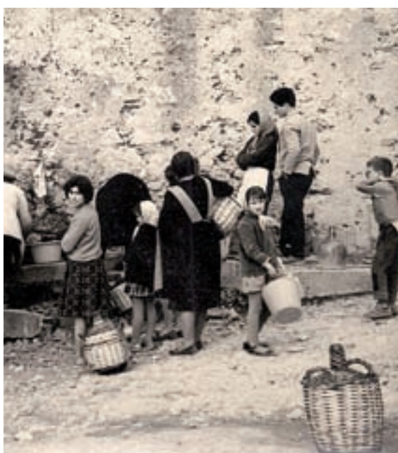
dipòsits d'aigua a la torre de defensa de Sant Joan.
