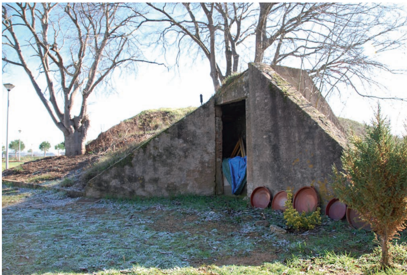
>> Entrada del refugi de l'aeròdrom de Vidreres.
