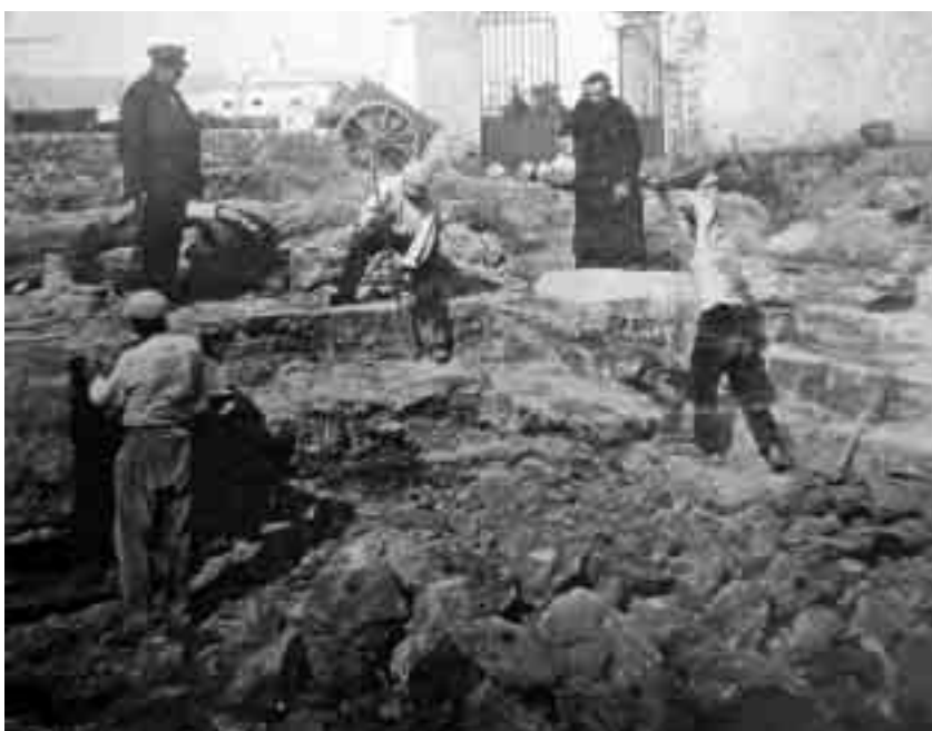
Vista parcial de les tasques d'excavació de les termes. La important capa de sediment calcaria que s'havia dipositat sobre les restes obligà a excavar a base de barrinades i cops de mall.
