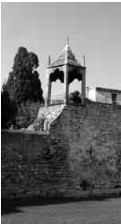
Aspecte que ofereix el portal de Can i el tram de muralla, després de la seva adequació; o com a zona verda.
