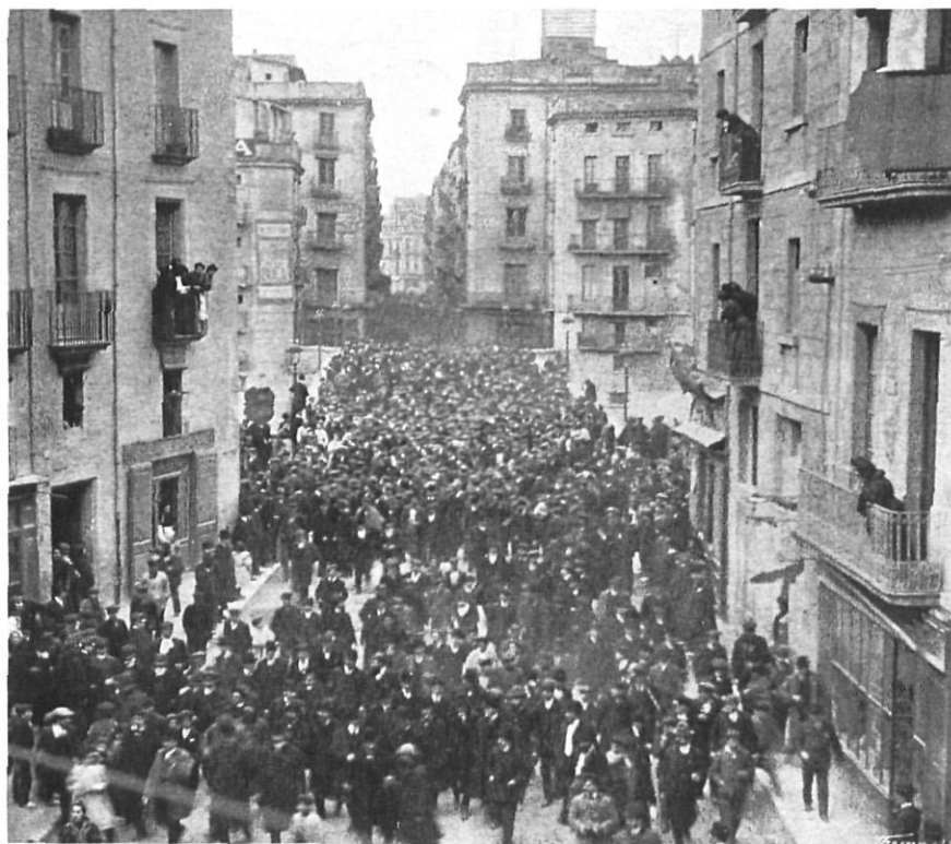
La comitiva, al seu pas pel carrer Nou i el pont de Pedra.
