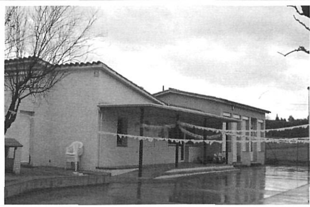
Les antigues escoles de Miànigues, construïdes l'any 1957, han estat rehabilitades i ampliades per acollir la Llar d'Infants Municipal Els Trapelles.
