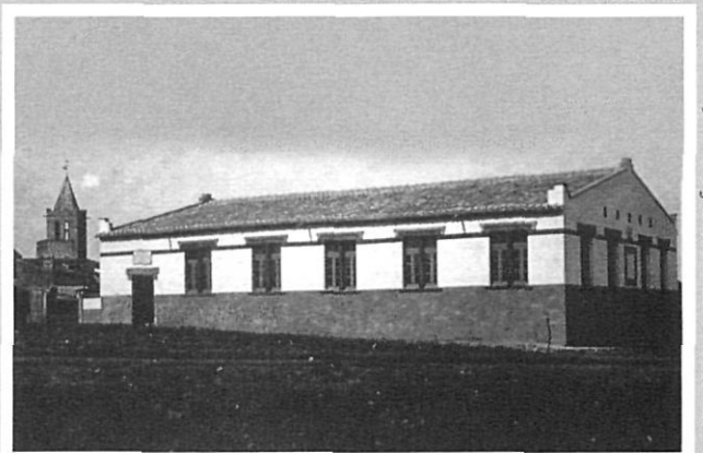
A Maçanet de la Selva, després de la inauguració del nou grup escolar l'any 1978, s'enderrocà l'edifici construït per Bonaventura Conill l'any 1922 (ampliat durant la República) per aixecar en el seu lloc l'edifici de l'actual Ajuntament.
