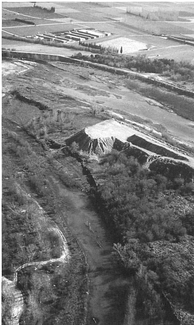
Aspecte del meandre de Torroella de Fluvià poc després de la canalització a mitjan 90. A dalt s'observa el nou canal i a sota l'antic meandre ja aïllat de la resta de riu. Actualment aquesta antiga llera és totalment seca.
