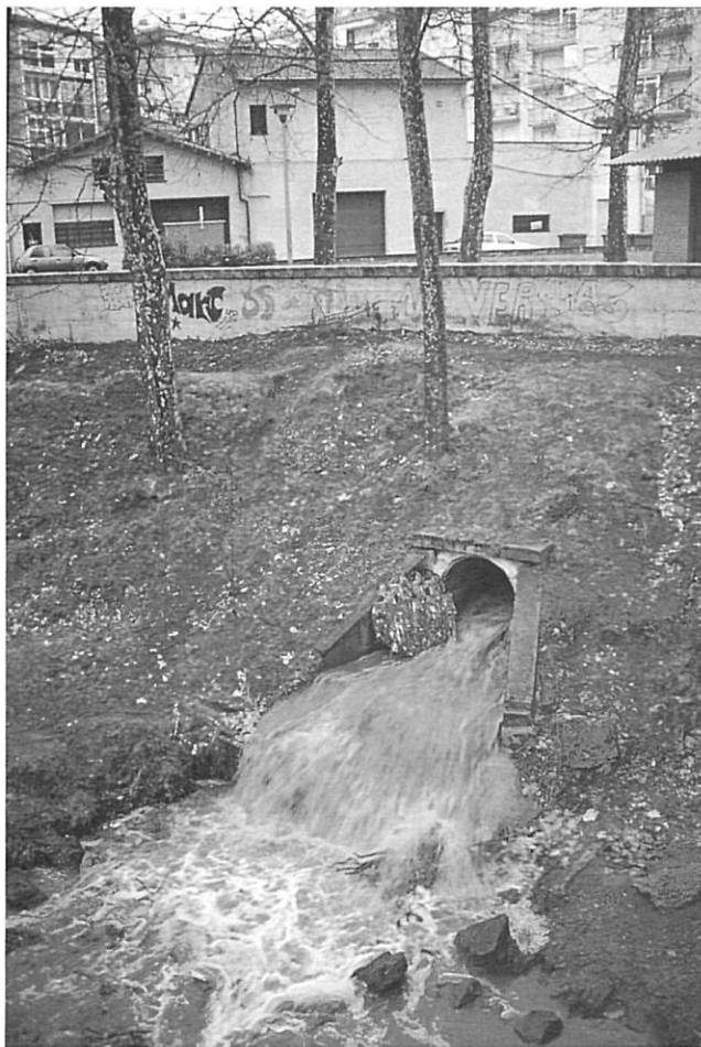
Sobreixidor del col·lector d'aigües residuals d'Olot abocant aigües sense tractar al Fluvià.
