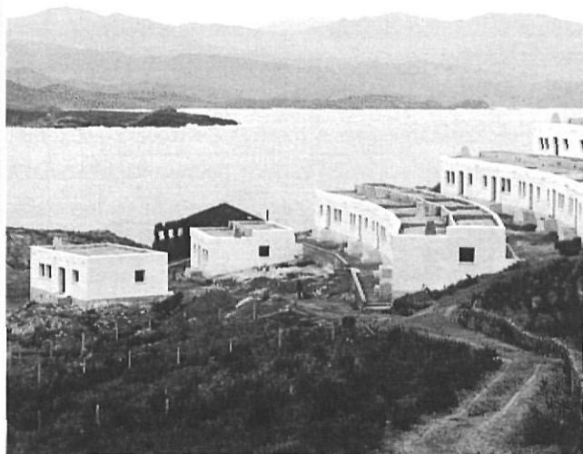
Pels volts de 1945 l'arquitecte va projectar aquest conjunt d'habitatges de baix cost destinats a cases dels pescadors de Port de la Selva.
