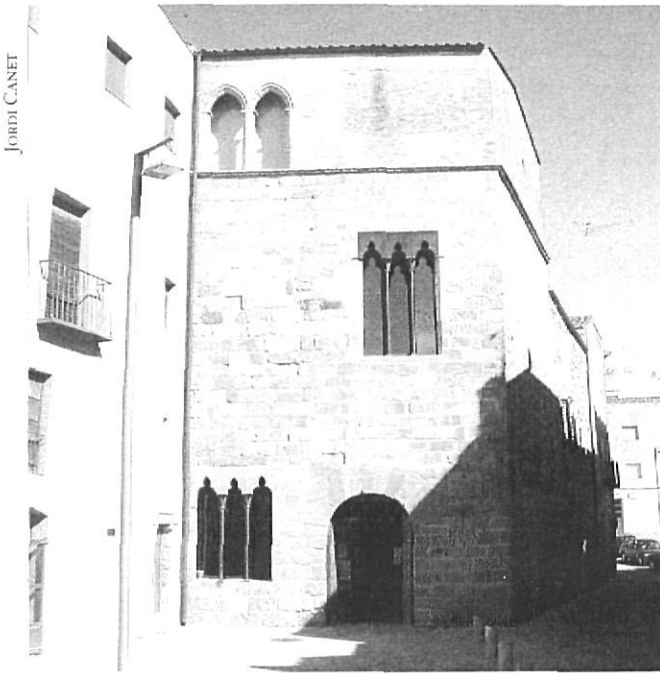
La Cúria o Cort de l'Audiència fou el centre administratiu i judicial del comtat. A la planta baixa hi havia la notaria dels comtes i a la planta superior l'arxiu comtal.
