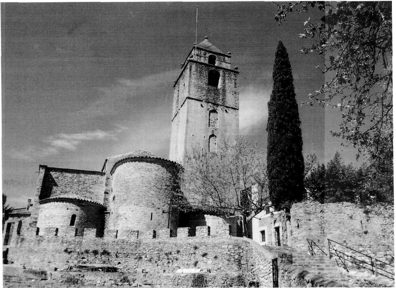
Capçalera i campanar de l'església de Sant Llorenç de la Muga.
