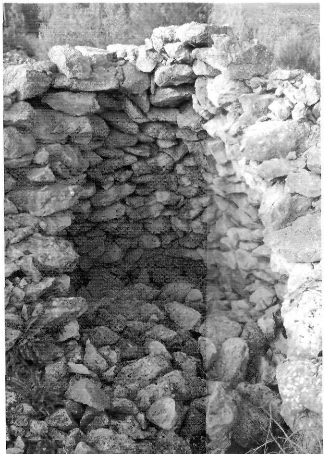
Tancament exterior de la falsa volta en una barraca de tradició semiesfèrica.
