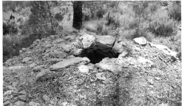
Tancament exterior de la falsa volta en una barraca de tradició semiesfèrica.
