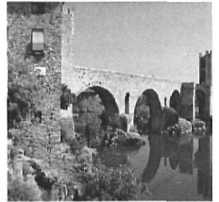
El pont de Besalú
